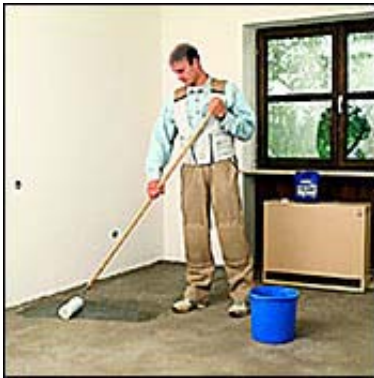
Aplicación de imprimación
